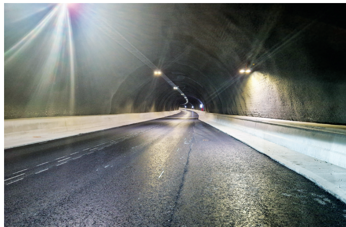
En svakhetssone i tunnelen gjorde at et parti på 70 meter måtte støpes ut med en meter tykk betong og omfattende armering.
