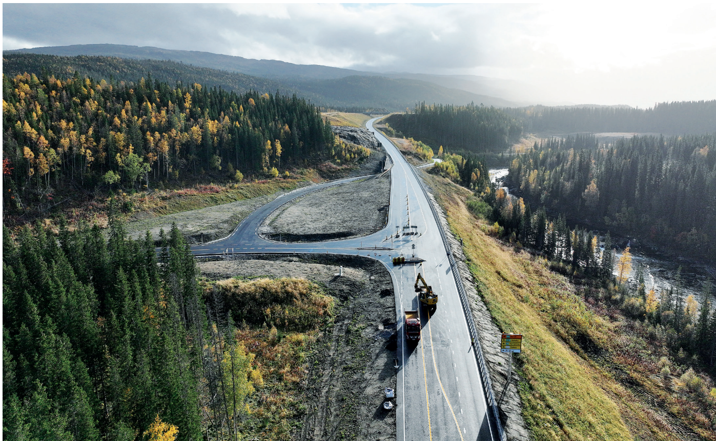
Valryggen bru er en betongkassebru på 387 meter fordelt på sju spenn som krysser Vefsna rett sør for Trofors.
